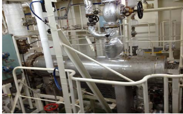
Figure 8-19 LNG vaporizer on an LNG gas carrier
